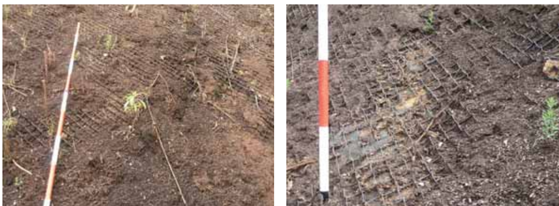
写真 4.4 侵食状況 ラス金網の露出状況（写真左）、地山の露出状況（写真右）の例
