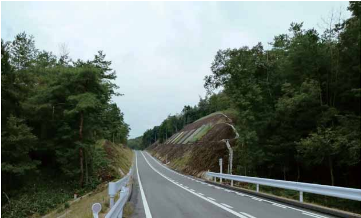
写真 2.2 試験法面周辺の植生状況
