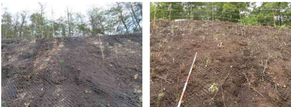
写真 4.5 ラス金網の露出状況
