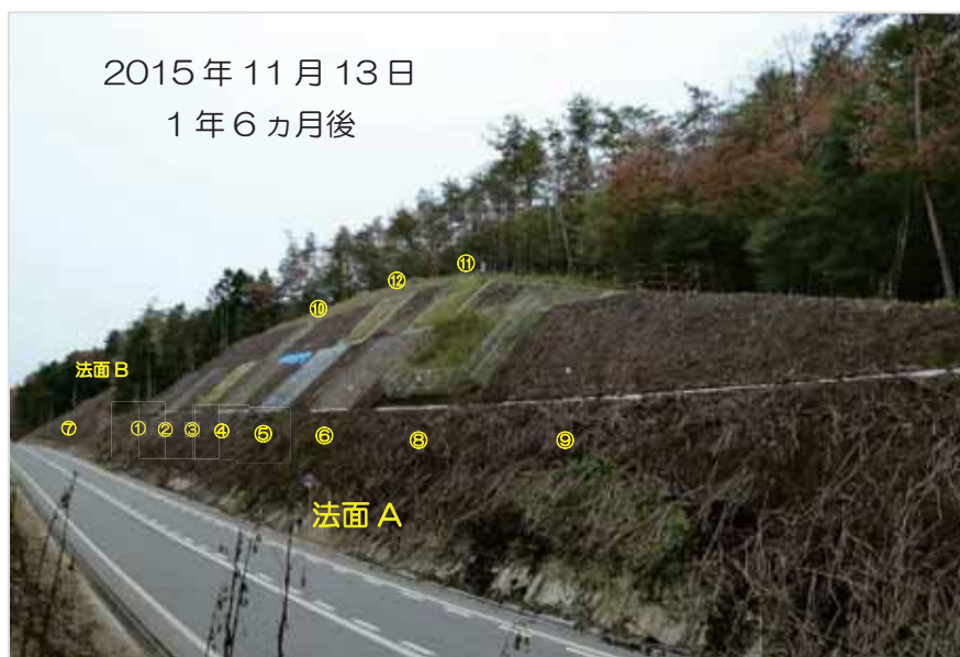
口絵写真 シカ対策試験工事の試験区経過（下から2および3段目法面が対象）
