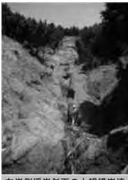
左岸側渓岸斜面の大規模崩壊
