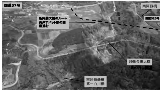
V字状に深く開削された谷の両岸の急崖部の岩盤崩壊 32
