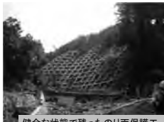
健全な状態で残ったのり面保護工
