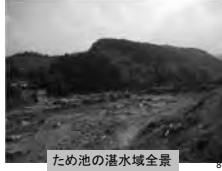
ため池の湛水域全景
