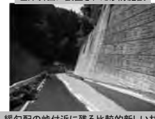
緩勾配の峠付近に残る比較的新しい林道
