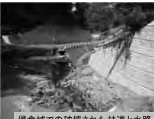
侵食域での破壊された林道と水路
