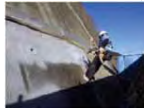
樹脂吹付状況
