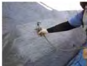
トップコート吹付状況
