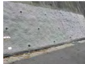
樹脂吹付完成
