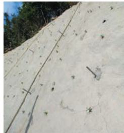
地山補強土工、下地処理完了
