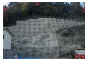
地山補強土工＋補強部材設置完了
