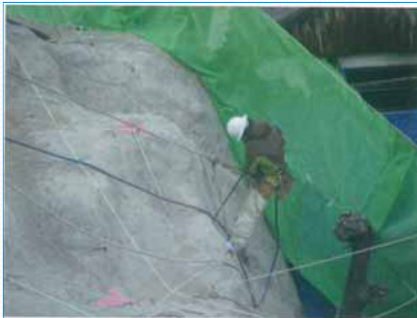
施工状況 (L 型アンカー)
