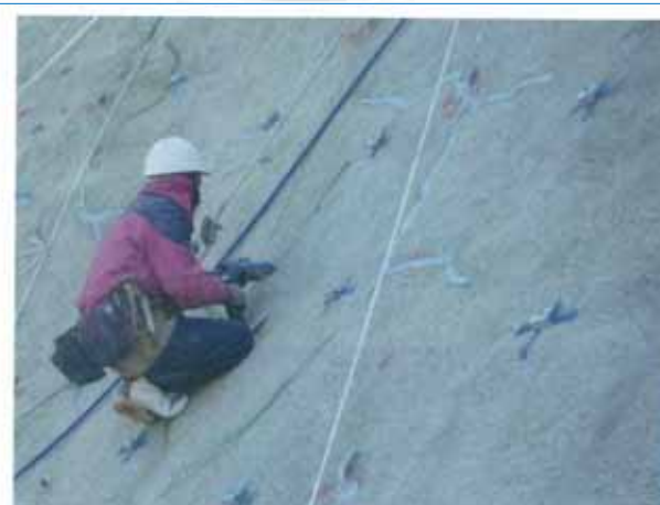
施工状況 (U 字カットシーリング)
