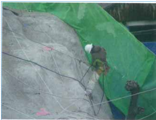
補強鉄筋工(例)
