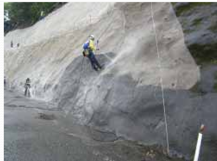
のり面洗浄工(例)
