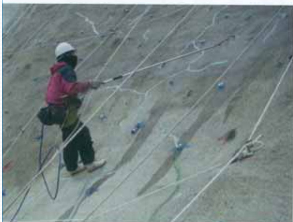
施工状況 (コンクリート改質剤散布)
