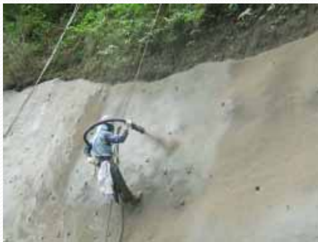
繊維補強モルタル吹付工(例)
