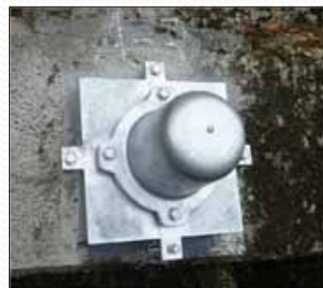
鋼製キャップへ交換 (固定用のカバープレートを設置)
