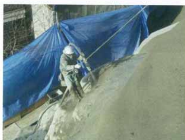
施工状況 (繊維補強モルタル吹付)
