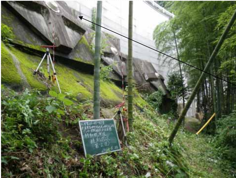
道路拡幅盛土における 斜面安定対策アンカー工
