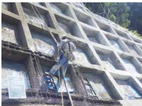
法枠吹付状況
