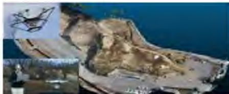
① UAV等による3次元測量
