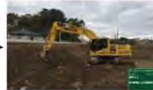
③ ICT建設機械による施工
